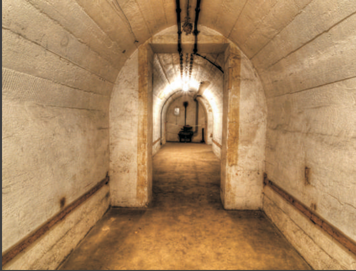
Blick durch den Mittelteil.
